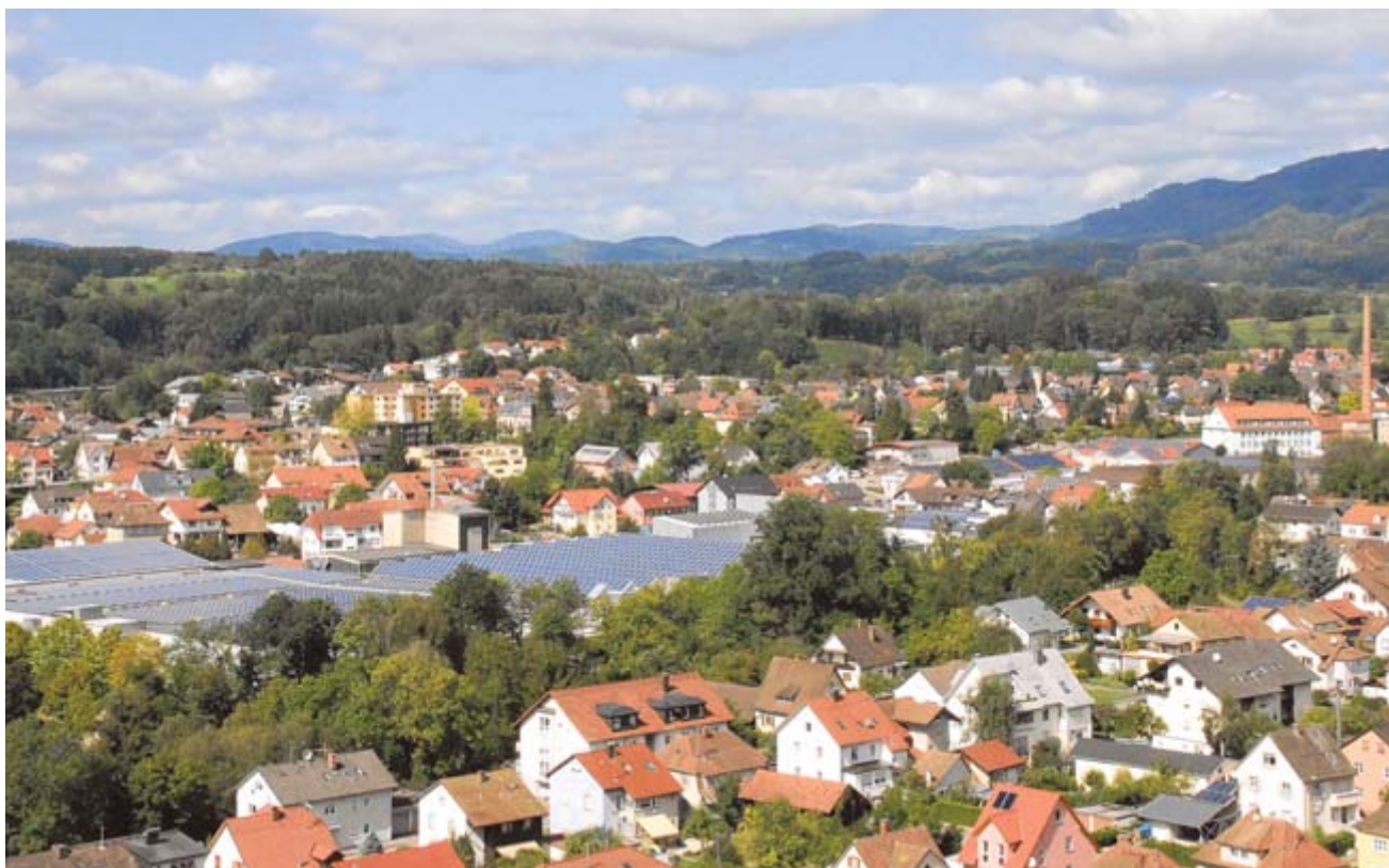
Viel Strom aus der Sonne: Hauptsächlich auf den Dächern der Brennet und der ehemaligen Wehra AG gibt es derzeit große Photovoltaikanlagen. Nun sollen auf einigen städtischen Gebäuden weitere hinzukommen. BILD: OBERMEYER
