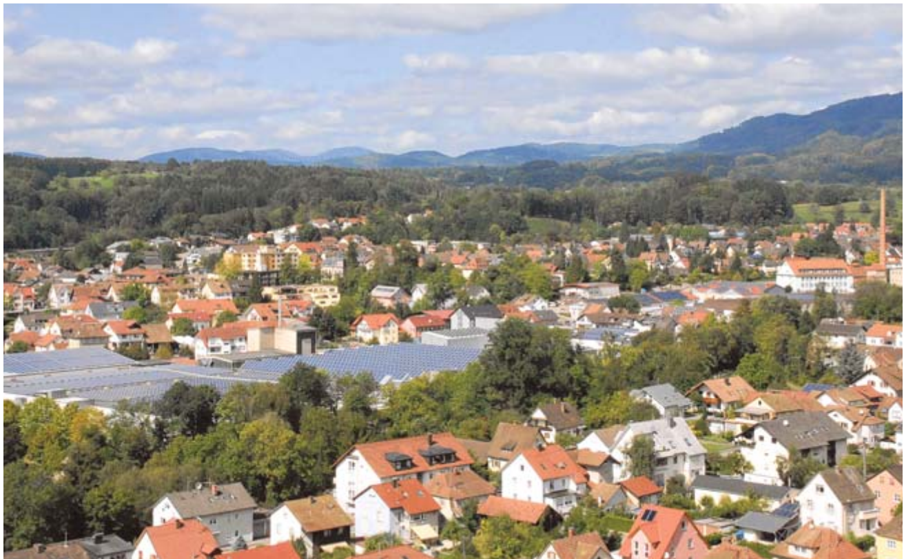
Viel Strom aus der Sonne: Hauptsächlich auf den Dächern der Brennet und der ehemaligen Wehra AG gibt es derzeit große Photovoltaikanlagen. Nun sollen auf einigen städtischen Gebäuden weitere hinzukommen. BILD: OBERMEYER
